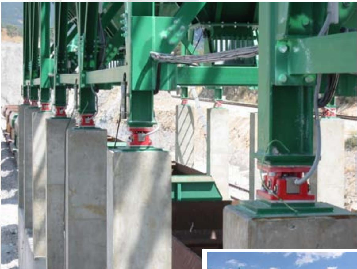
● La fotografía muestra la instalación de células para pesaje en una serie de tolvas
